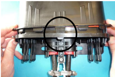
Centring pins insertion Insertion des doigts de centrage
